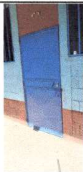
Foto 3: Mantenimiento a puertas de metal en aula 1, 2, 3, 4
