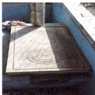
Foto 11: Sustitución de plancha de metal de 3 hornillas en cocina
