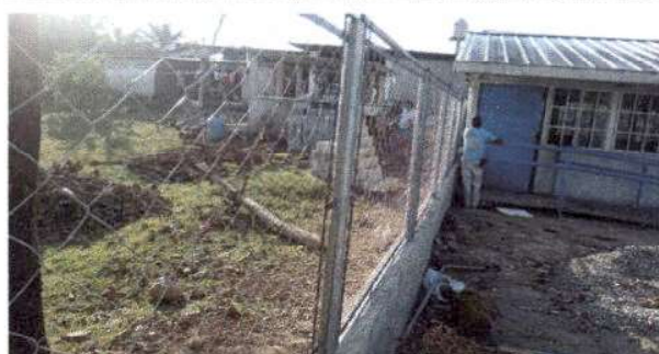
Foto 2: Reparación de Tubo HG y malla galvanizada en muro perimetral
