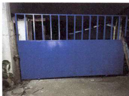
Foto 8: Fabricación e instalación de portón de metal de ingreso principal
