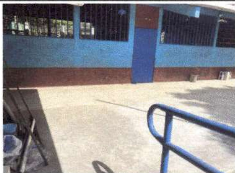
Foto 9: Sustitución de piso de tierra por torta de concreto
