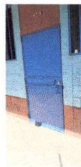
Foto 4: Sustitución de chapa en puertas de metal en aula 1, 2, 3, 4
