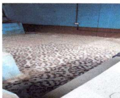
Foto 10: Sustitución de piso de torta de concreto por piso cerámico en cocina
