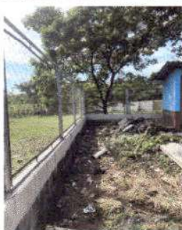
Foto 1: Reparación de block con tubo HG y malla galvanizada, soleras intermedias y columnas en muro perimetral
